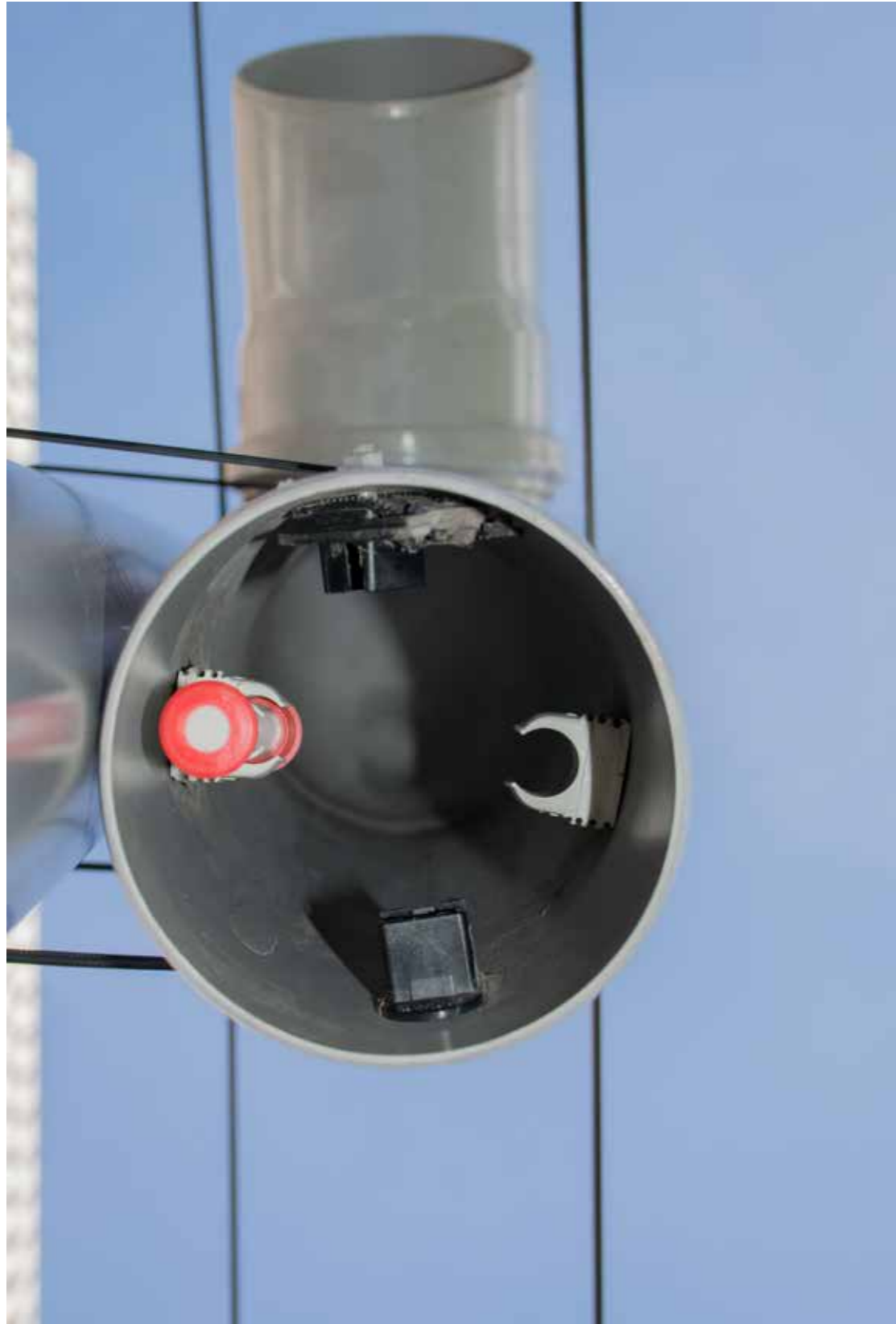
Installation « tube à diffusion passive »
